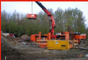
Travaux de construction
