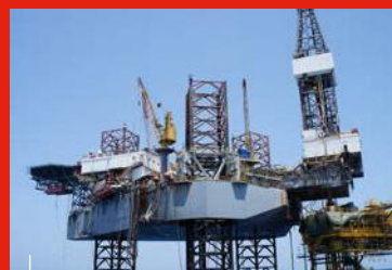
Plateformes de forage
