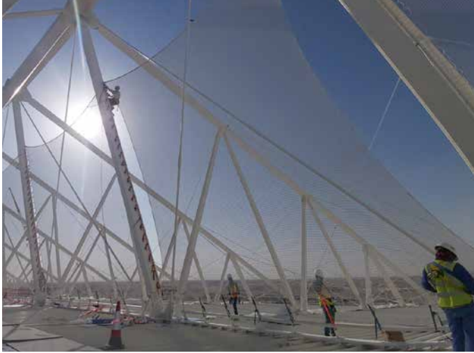
Filets de protection brise-vent pour la Coupe du monde de football au Qatar
