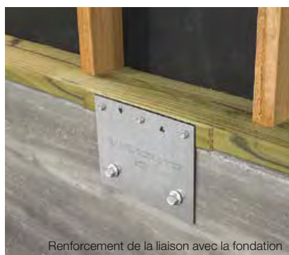
Renforcement de la liaison avec la fondation
