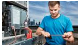
4. Nettoyez l'extrémité du tube avec un mouvement circulaire en évitant les rainures parallèles au tube.
