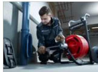
Nettoyage d'un tuyau de descente avec une Flexibles de 16 mm
