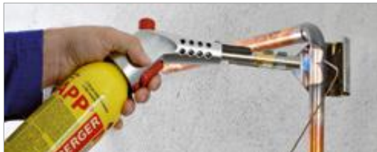
Brasage fort dans les installations de gaz
