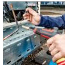
Brasage fort dans les installations de climatisation
