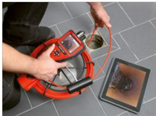
Inspection des conduites d'eaux de pluie
