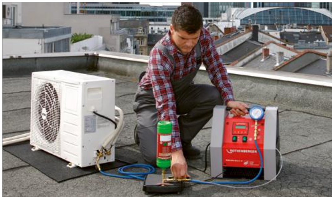
ROKLIMA® MULTI 4F en cours d'utilisation (vide final et remplissage)
