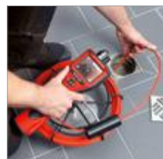
Inspection de conduites d'évacuation des écoulements
