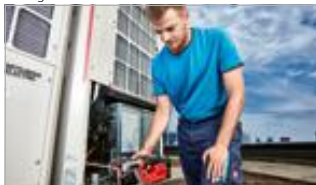
8. Alignez les mâchoires sur le raccord et sertissez
