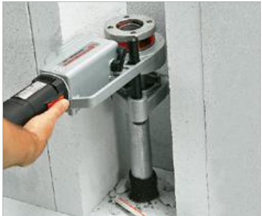
Travail en environnement restreint
