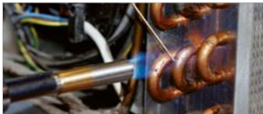
Brasage fort dans les installations de climatisation
