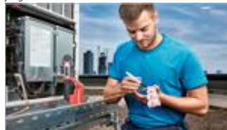
7. Marquez la profondeur d'insertion à l'aide de la jauge et insérez le tube à fond dans le raccord
