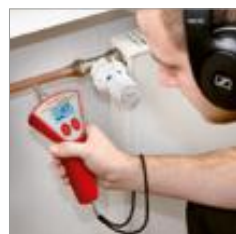
Détection de fuite acoustique dans les installations de chauffage
