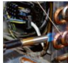
Brasage fort dans les installations de climatisation
